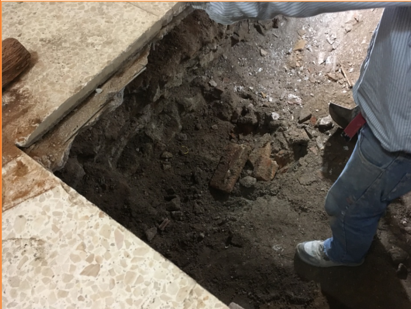
Foto 7. Inici dels treballs d'excavació del nivell UE 5.
