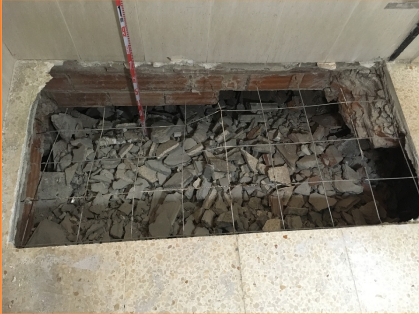
Foto 3. Estat final del forat de l'ascensor i vista de la UE 2.
