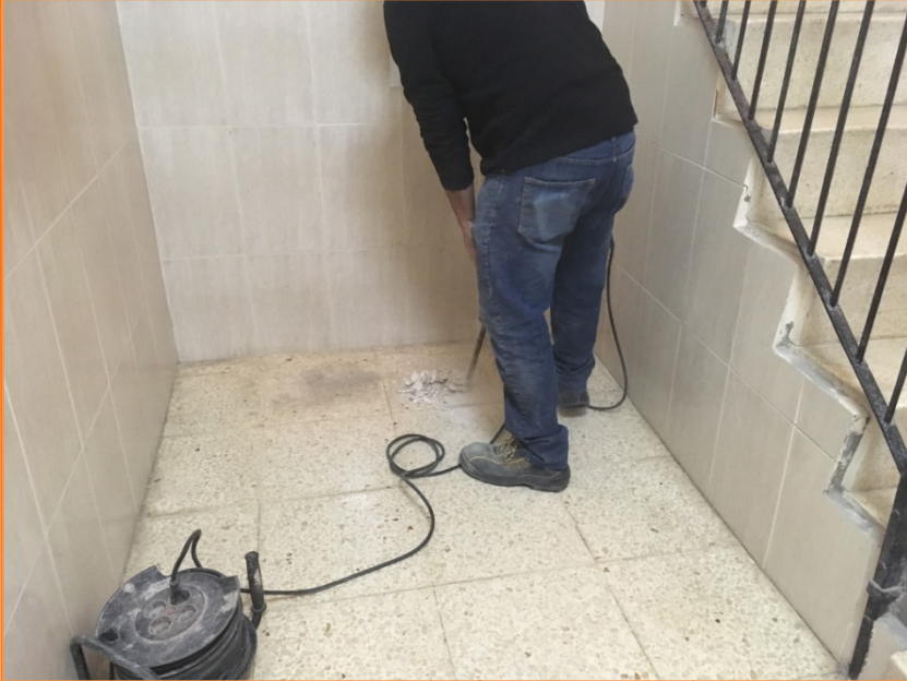
Foto 1. Inici dels treballs d'extracció UE 1.
