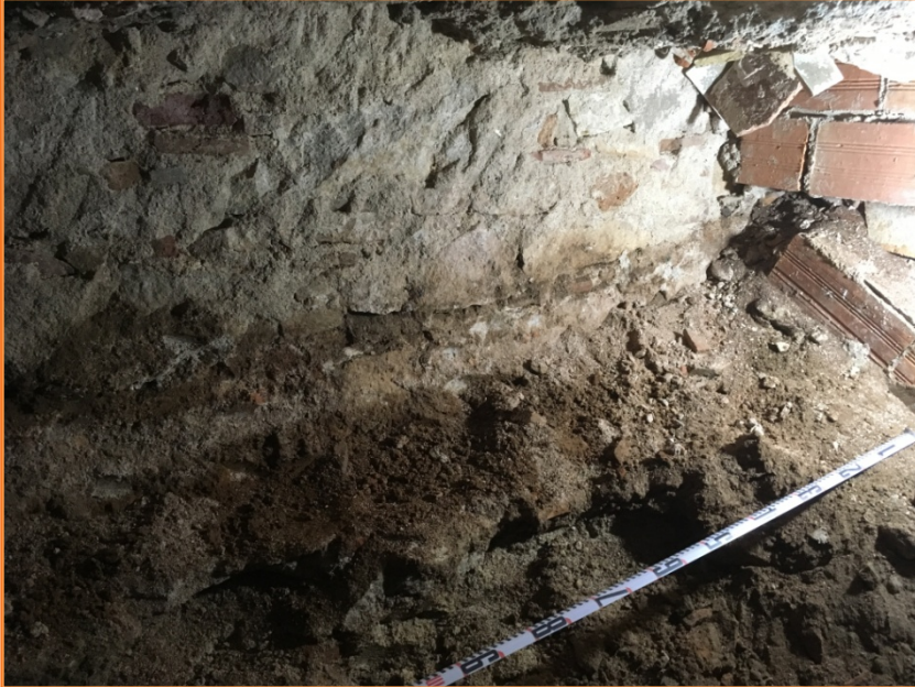
Foto 5. Vista del mur UE 3 des de l'interior del dipòsit.
